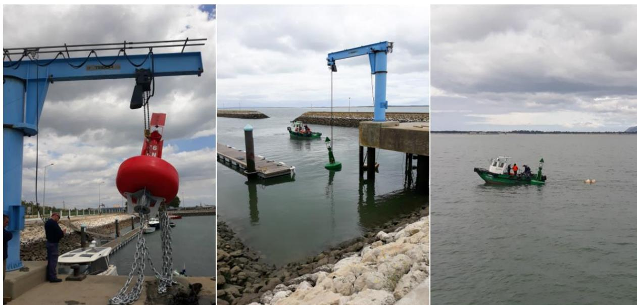
O Porto de Setúbal concluiu a ação de assinalamento marítimo do canal de navegação Norte, tendo consistido os trabalhos na instalação de quatro novas boias (duas vermelhas e duas verdes), equipadas com lanternas para assinalamento noturno e deslocação de uma das boias já existentes.
